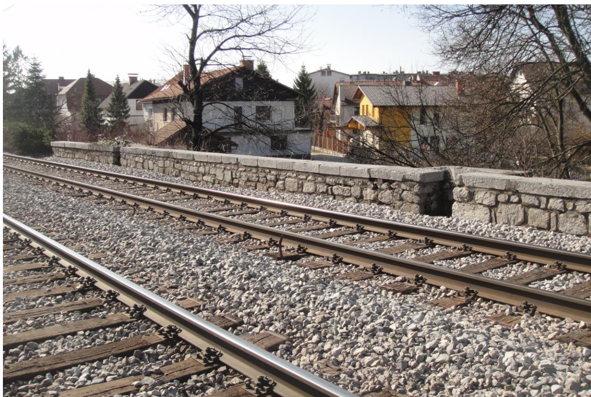
Slika 4 – Pogled iz vzhodne strani na zgornji ustroj s tiroma in parapetni ograji
