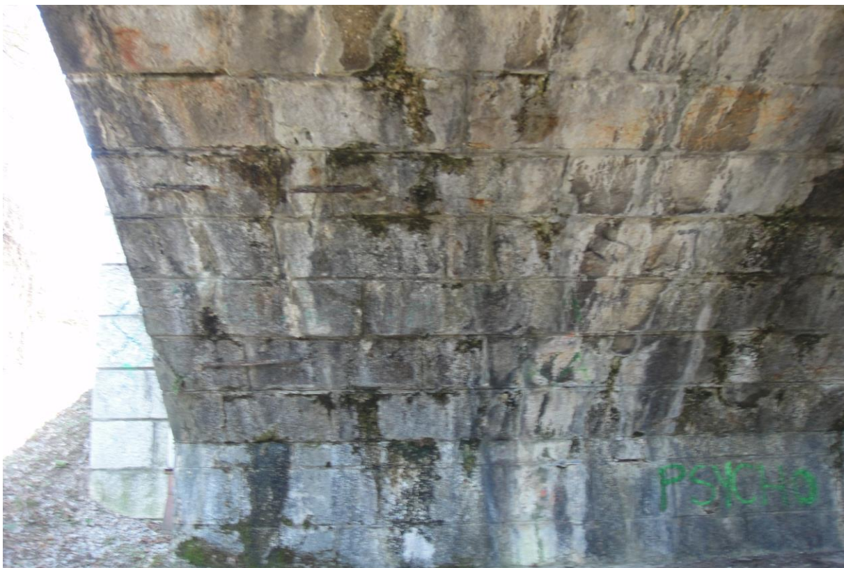
Slika 17 – Zasiganost kamnitih kvadrov in stikov med njimi
