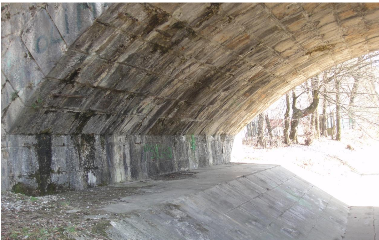
Slika 27 – Struga Glinščice s koritom in brežinama pod mostom
