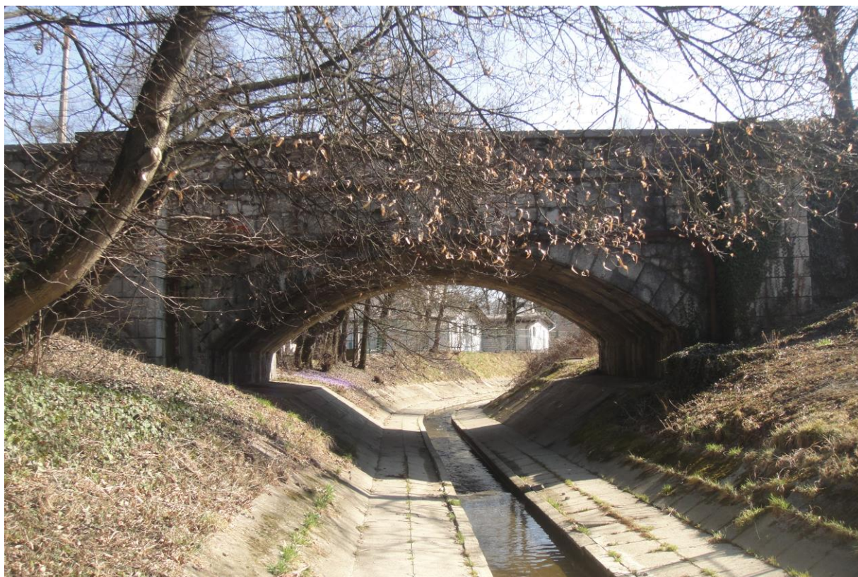
Slika 1 – Pogled na most s severne strani
