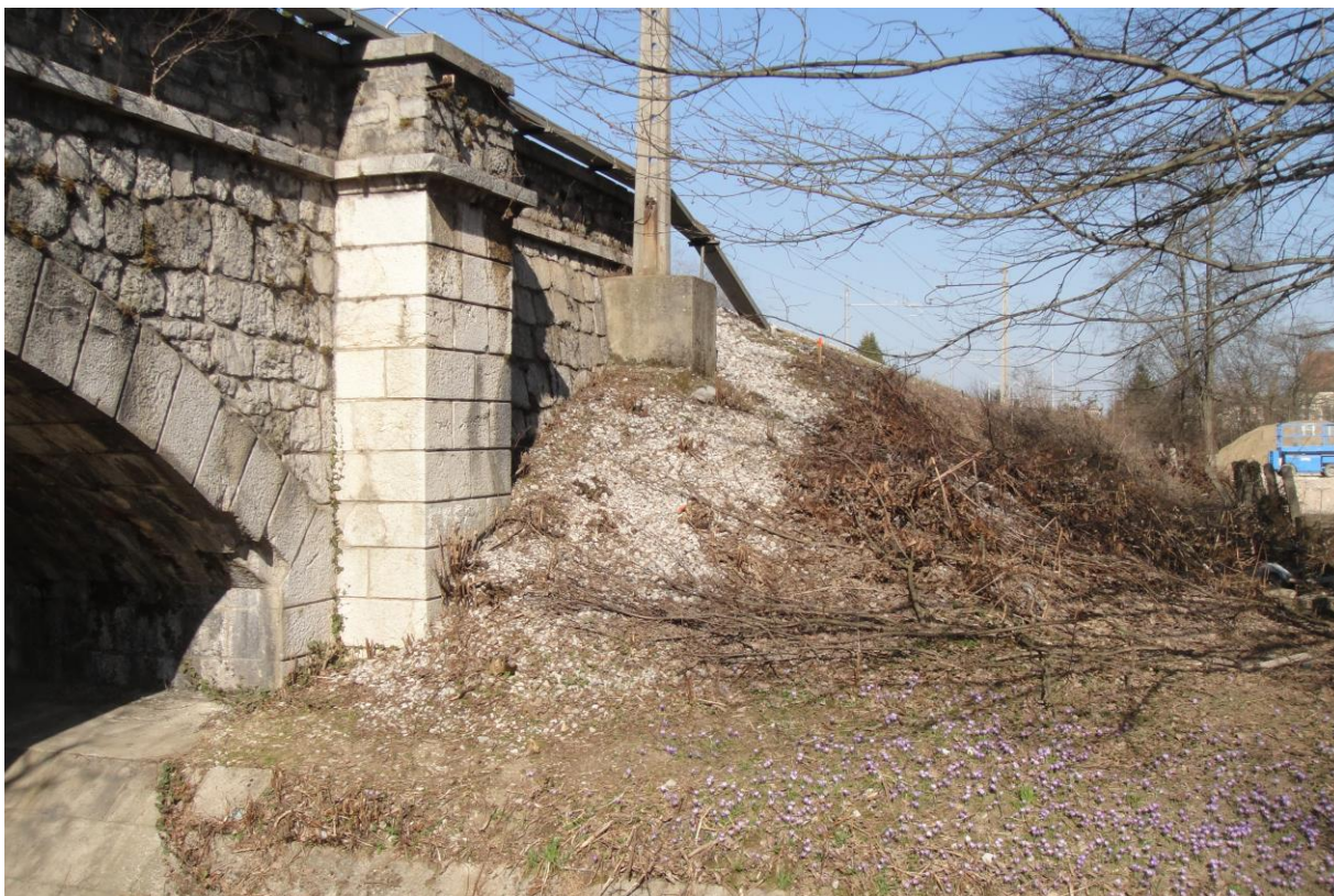
Slika 24 – Drog VO na jugovzhodni strani objekta
