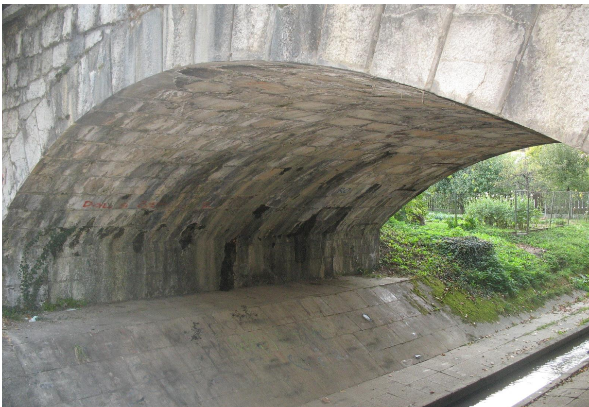
Slika 26 – Struga Glinščice s koritom in brežinama pod mostom
