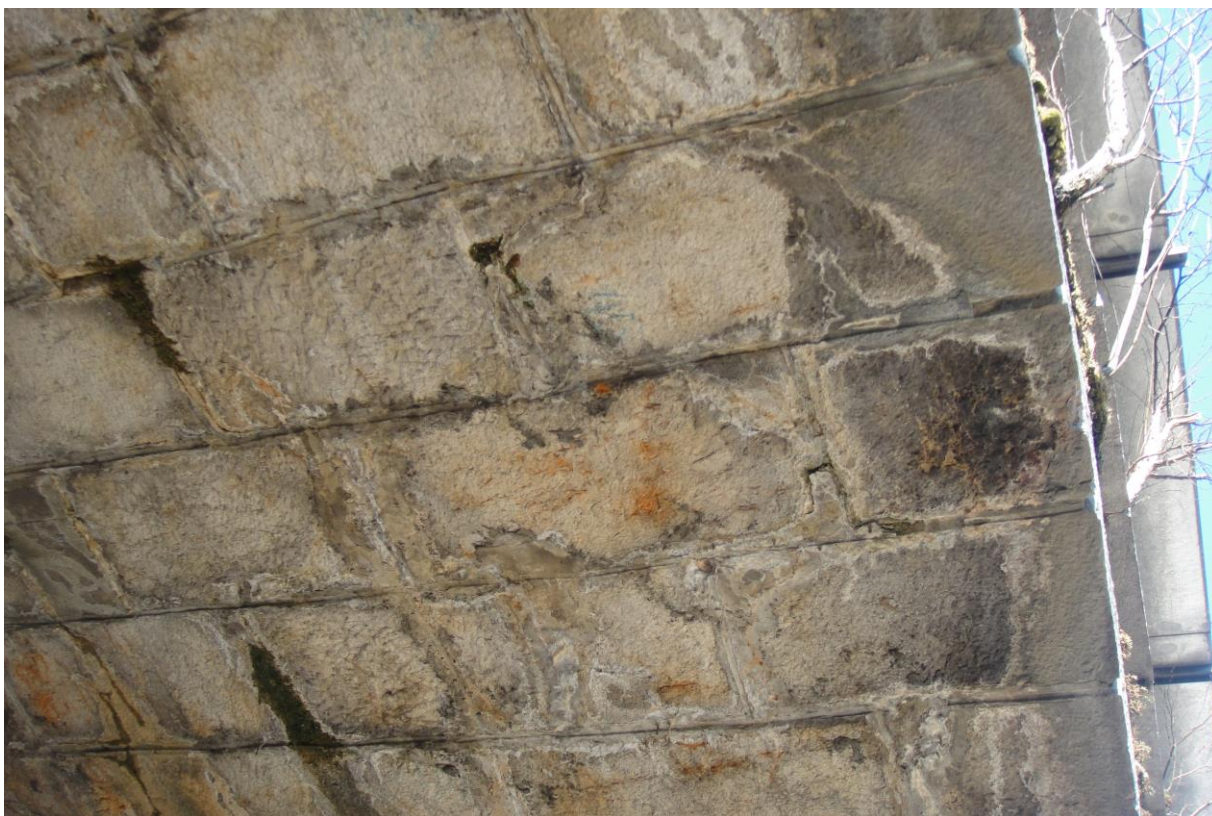
Slika 9 – Zasiganost kamnitih kvadrov in stikov med njimi
