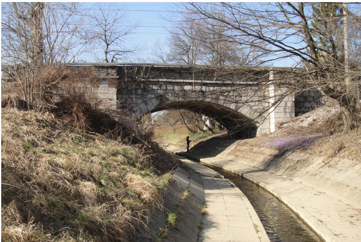
Slika 2 – Pogled na most z južne strani
