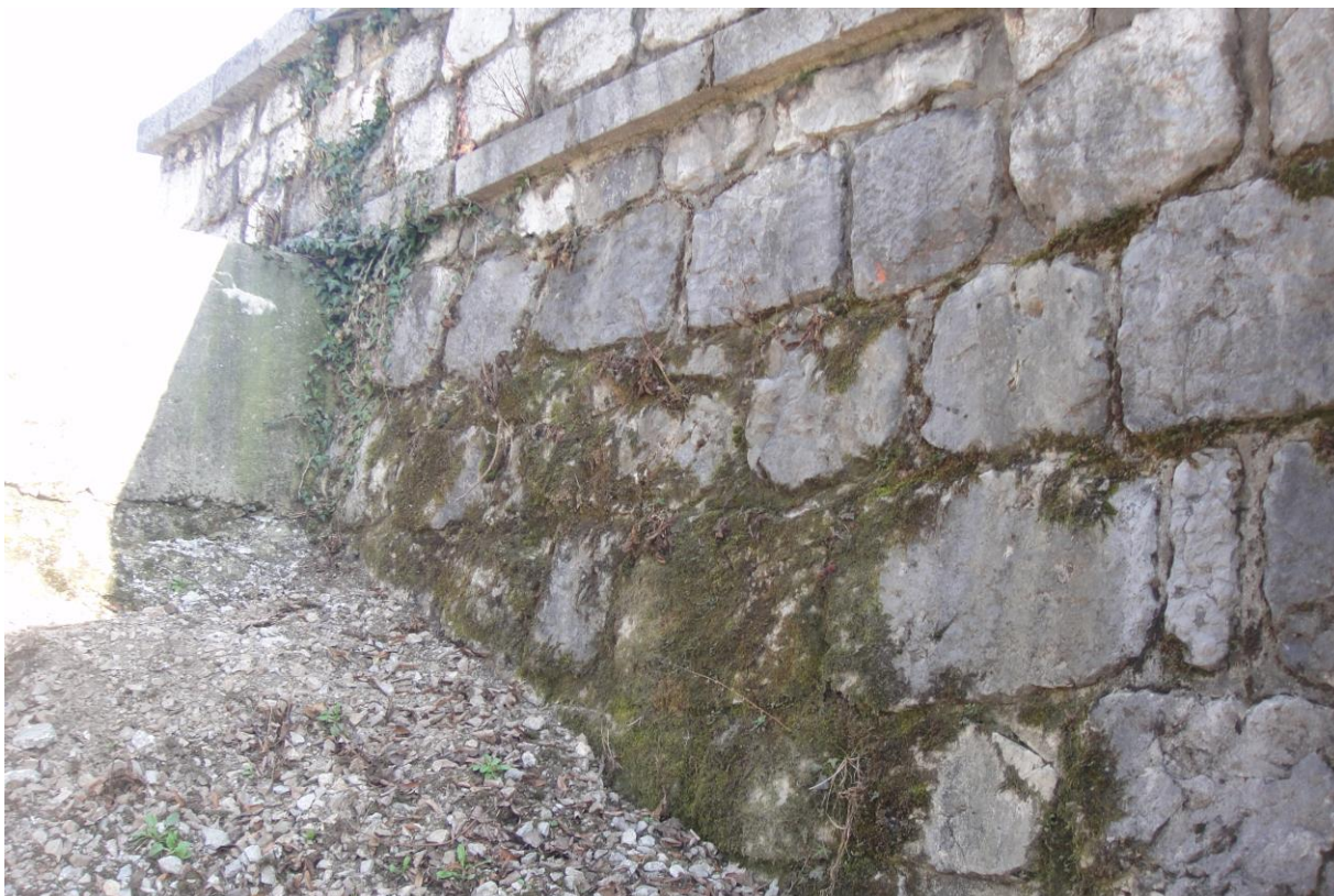
Slika 18 – Obraščenost z mahom severovzhodnega krila
